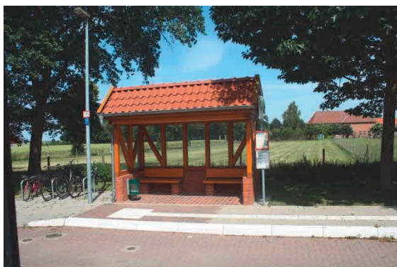
Die neue Bushaltestelle ist für Menschen mit Beeinträchtigung barrierefrei gebaut
