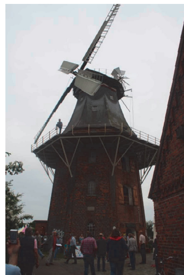
Vom HVV restaurierte Fehsenfeldsche Mühle
